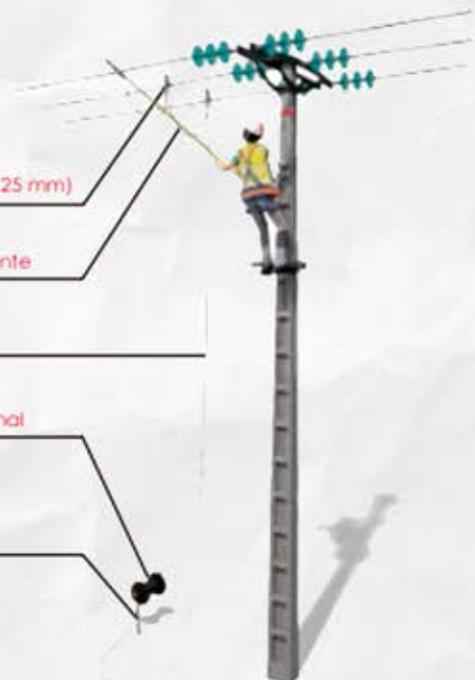
Sistema patentado de colocación de pinzas una encima de otra, brindando mayor maniobrabilidad en la operación y reduciendo el esfuerzo del operario.
